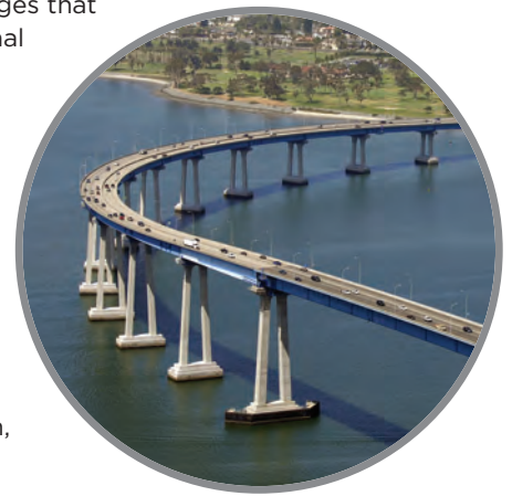
San Diego-Coronado Bridge
