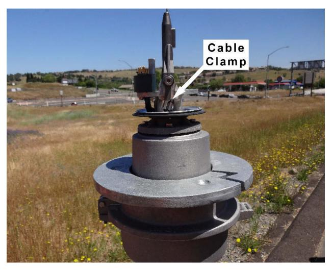
Figure 43. MG<sup>2</sup> External-Type CLD Cable Clamp
