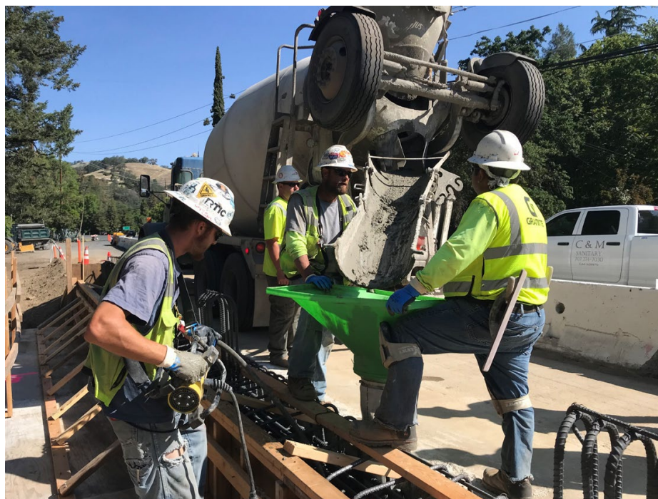
Figure 6-12. Concrete Barrier Pour
