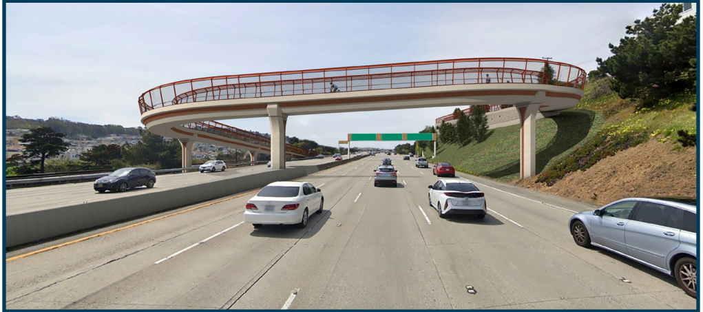
Cầu vượt dành cho người đi bộ hiện tại tại Farallones Street
