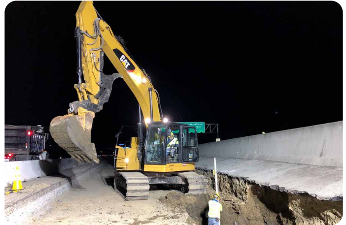
Equipos de construcción excavando en una sección del arcén de la autopista.
