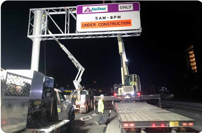
Equipos de construcción instalando una señalización en la mediana durante la fase uno.
