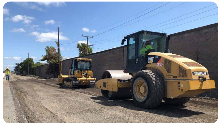
Equipos de construcción nivelando una sección nueva del arcén de la autopista en la fase dos.
