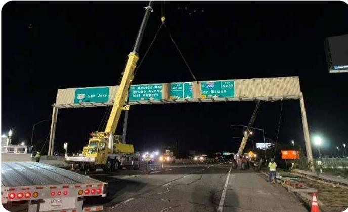
*Equipos de construcción removiendo una estructura existente de letrero elevado en la U.S. 101.*
