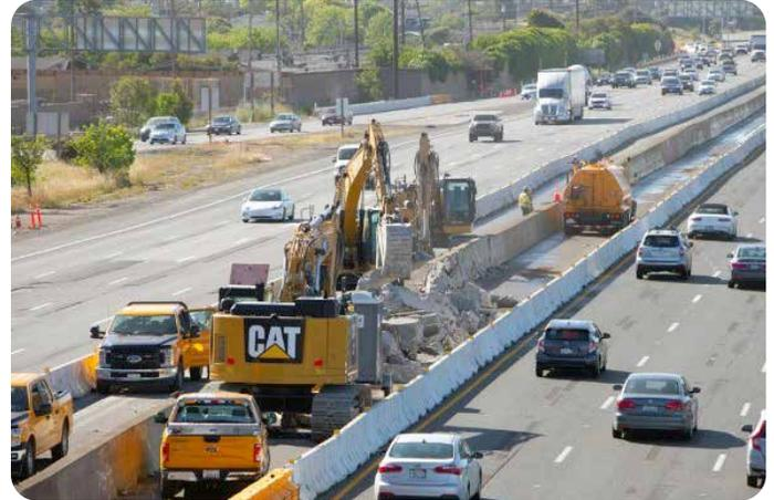
*Equipos de construcción demoliendo la barrera de la mediana.*
