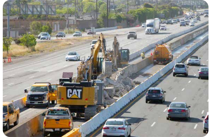
施工人员正在拆除中间道路屏障
