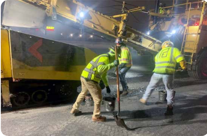
施工人员正在重新铺设Broadway以北的车道
