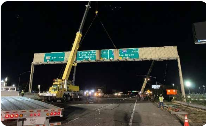
施工人员正在101号公路上拆除一个现有的高架标志
