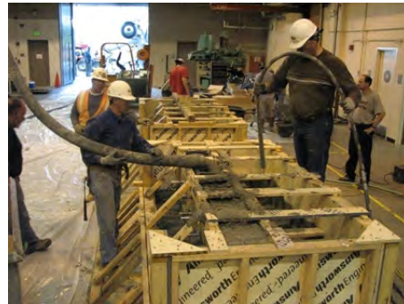
(d) Casting concrete
