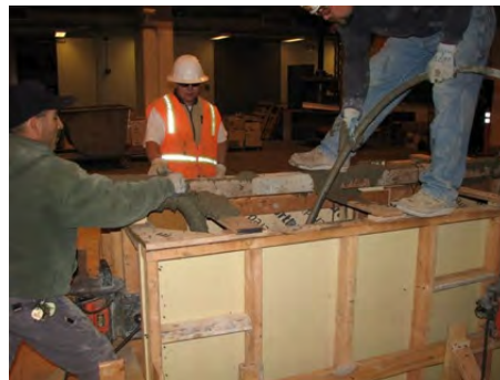
(d) Casting concrete
