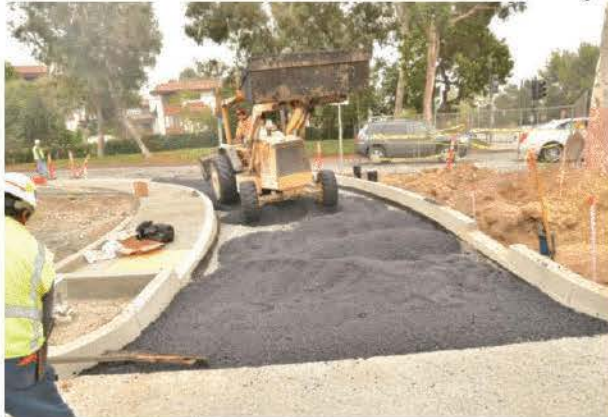
a) Pouring of asphalt mix
