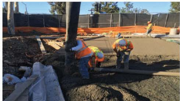
b) Pouring of concrete
