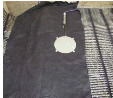
(b) LWA backfill
