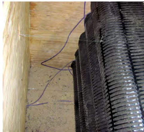
(b) LWA backfill
