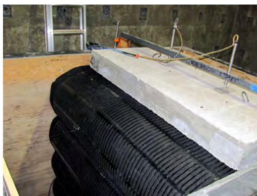
(b) LWA backfill
