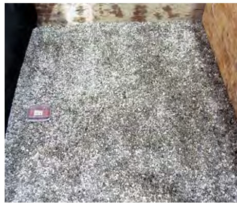
(b) LWA backfill
