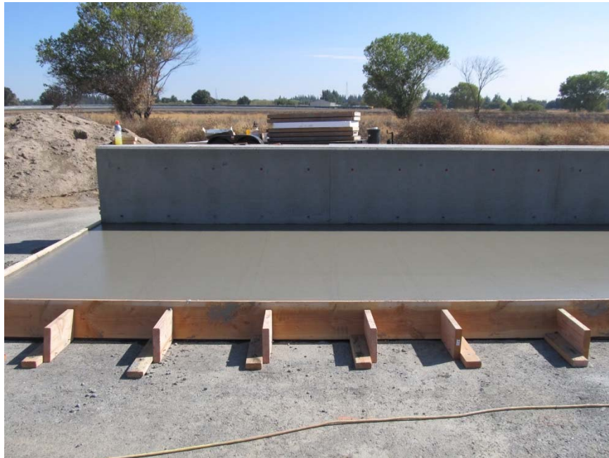
Figure 2-5 – Type 732SW after sidewalk pour
